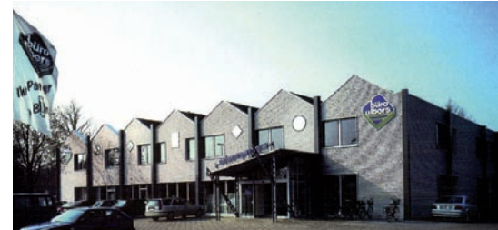
Büro-Albers-Standort in Papenburg
